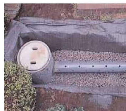
浸透ます施工状況
