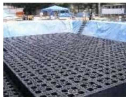
貯留浸透施工状況
