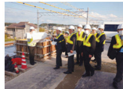
新駅建設中の現地を視察する様子
